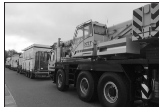
▲ Kolonne bouw materiaal + kraan
